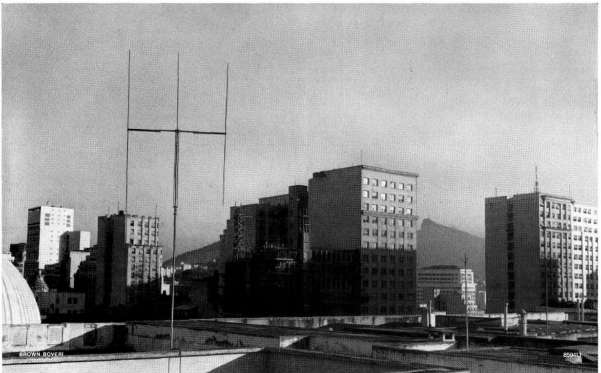
Bild 17 — Die Richtantenne auf dem Dach des Großstadt-Hochhauses vermittelt die Telefongespräche der Zentralverwaltung direkt zu ihren Fabriken in der Provinz
