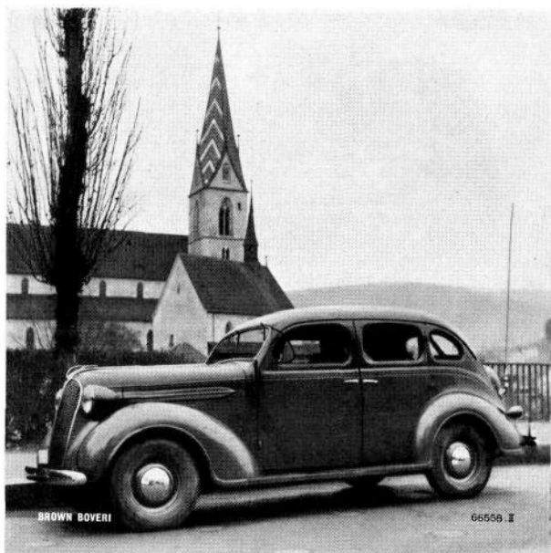
Abb. 7 — Personenauto mit Funkausrüstung für drahtlose Verbindung mit einer ortsfesten Station
