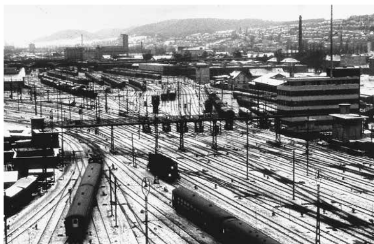
Bild 6: Teilansicht der Gleisanlagen in Richtung W vom neuen Hauptstellwerk aus, 1965. Rechts das Nebenstellwerk mit Antennenmast
